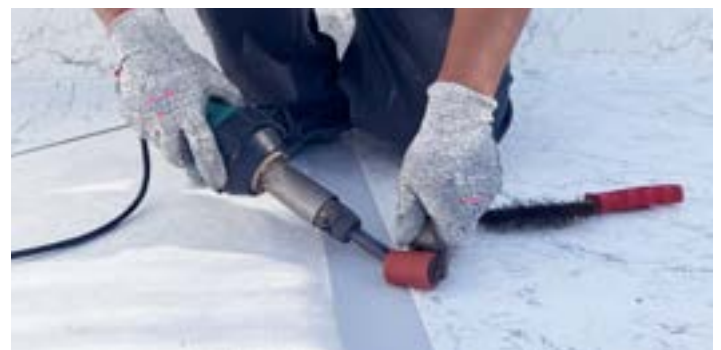
Saldatura testa a testa
