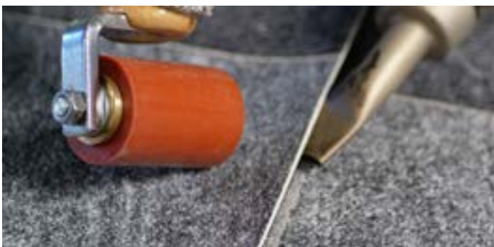
Saldatura con sormonto
