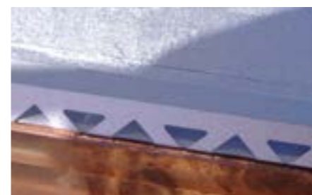
Dettaglio pannello sulla linea di gronda
