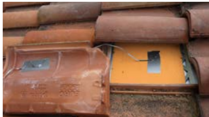
Foto 2 - Posa delle sonde di temperatura sulla copertura senza alluminio
