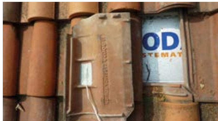
Foto 1 - Posa delle sonde di temperatura sulla copertura con alluminio
