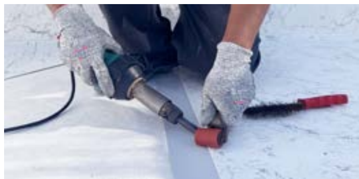
Saldatura testa a testa
